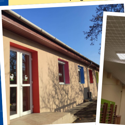
Széchenyi utcai óvoda szigetelése
