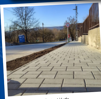
Elkészült a Bányató utcai járda
