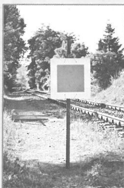
Vágányzár-jel a vasútállomás melletti vasúti átjáróban
