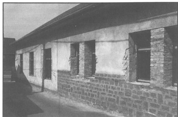
A megújuló Templom köz felőli homlokzat
