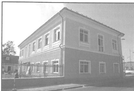
A Városháza felújított homlokzata és új kerítése a Csobánkai utca felől
