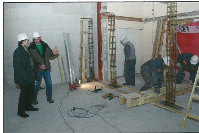
A munkások a galéria tartóoszlopainak betonozását készítik elő. Páva Gábor a műszaki részletekről ad tájékoztatást
