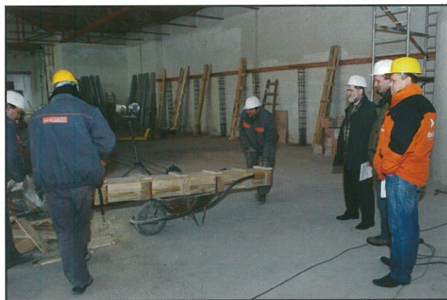
Elkészült az utolsó tartóoszlop zsaluzata is. A képen jobboldalt elől Botos Imre építésvezető
