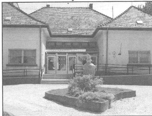
Az új bejárat a mozgáskorlátozottak közlekedését lehetővé tevő rámpákkal
