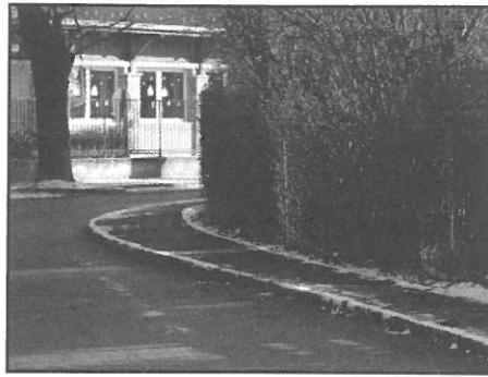
Aszfaltos járda épült a Rákóczi utcában
