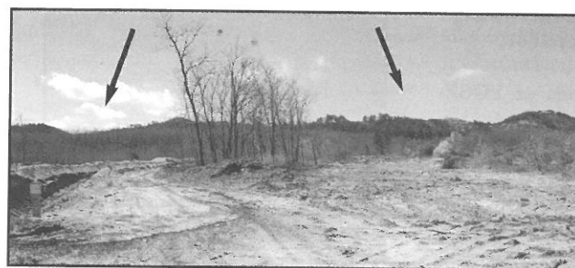
A gázvezeték elkerülő az illegális szeméttelérakót. Jobboldalt az eredeti, baloldalt a módosított nyomvonal
