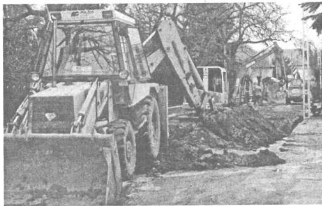
Csatornaépítés a Szegfű utcában Fotó: Rásonyi Győzőné
