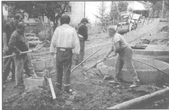
Épül a Pozsonyi utcai átemelő
