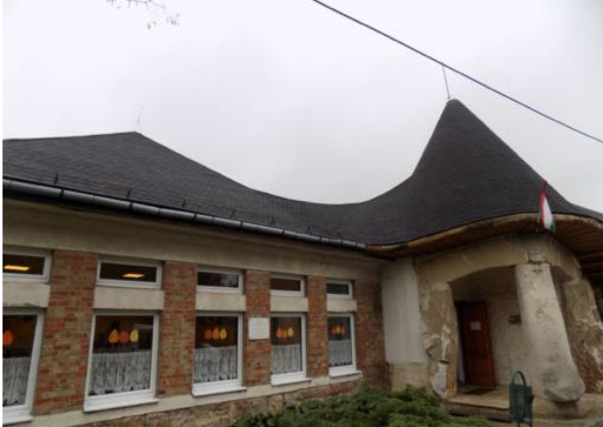
Grádus óvoda tetőfelújítás: 5.184.445 Ft
