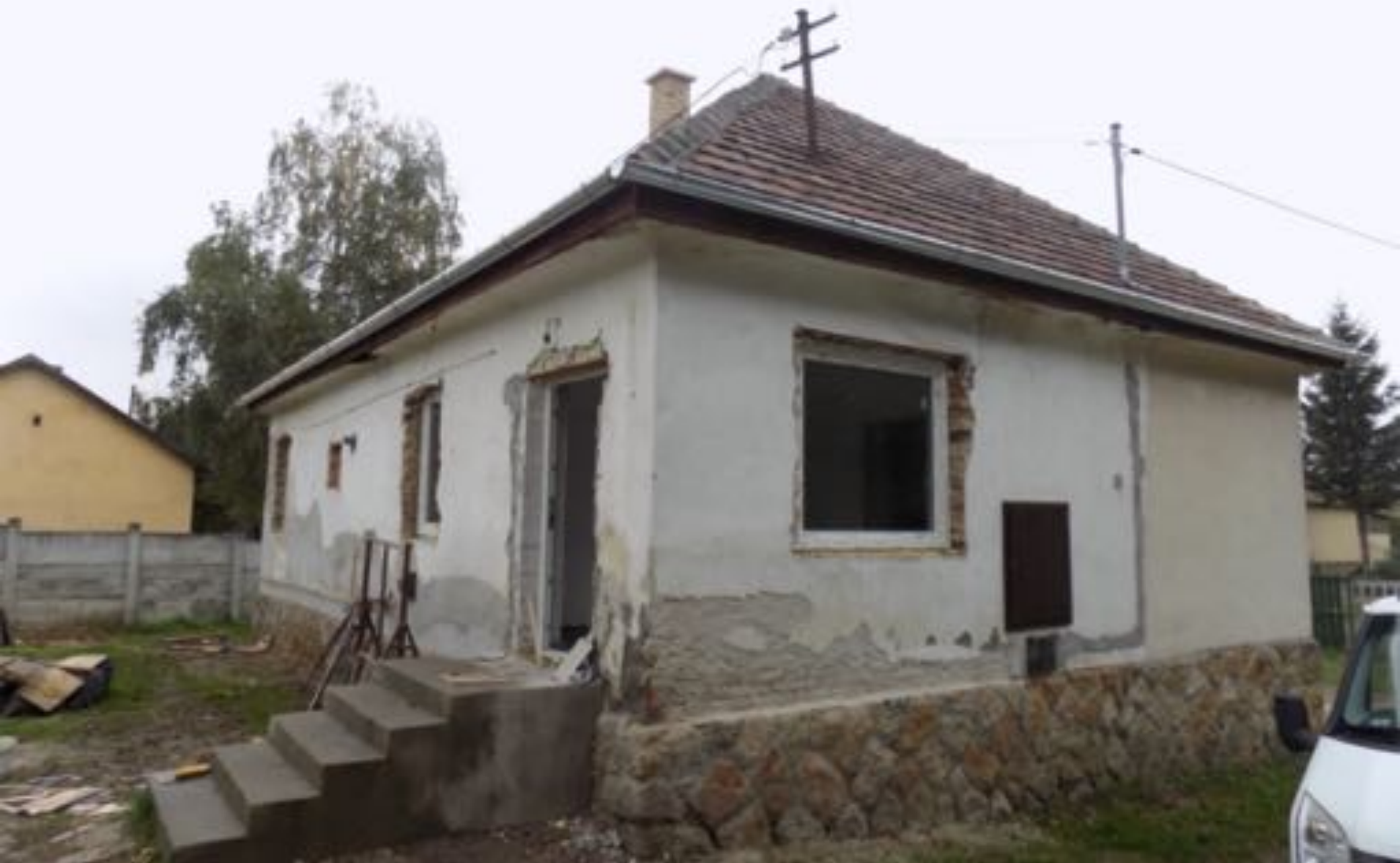
Temetőgondnoki lakás felújítása (folyamatban): 2.500.000 Ft
