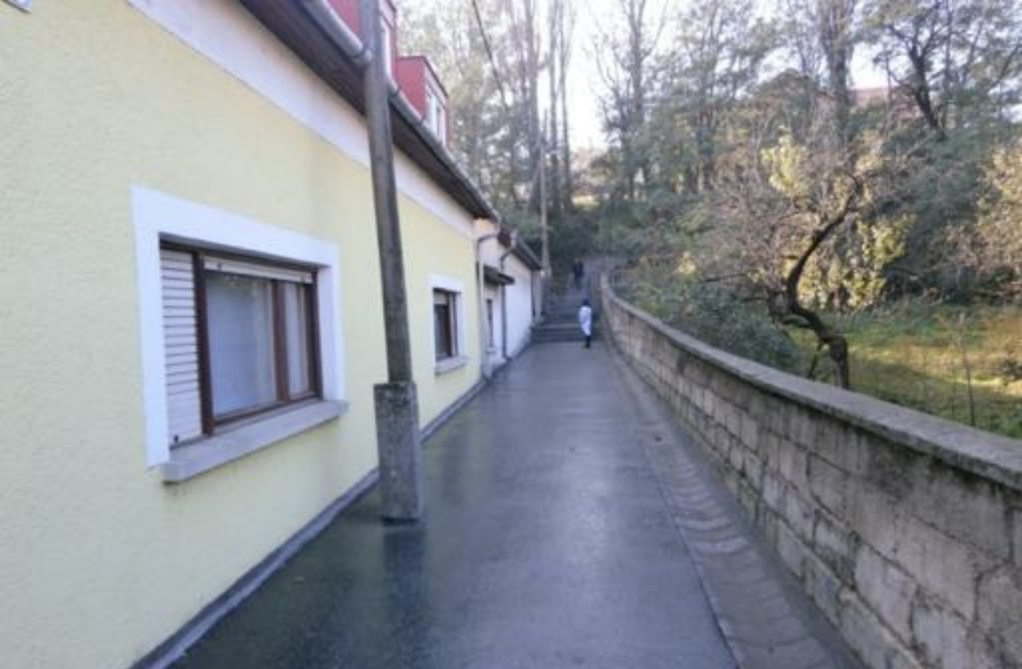
Vasútállomás felé vezető járda, lépcső: 3.937.000Ft
