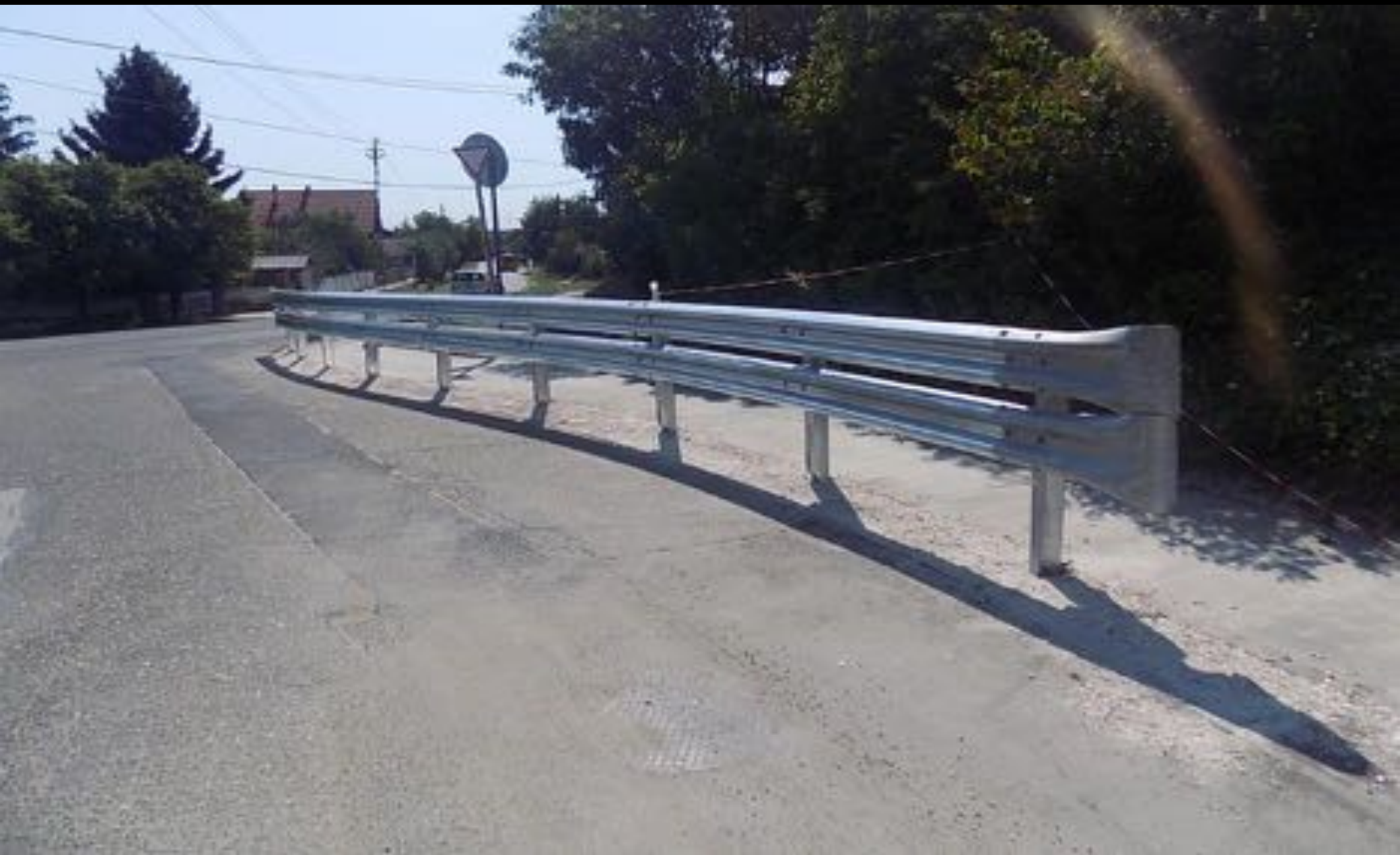
2017.09.15. Járdáépítés védőkorláttal a Nyár utca - Kisfaludy utca kereszteződésében 1 066 673 Ft
