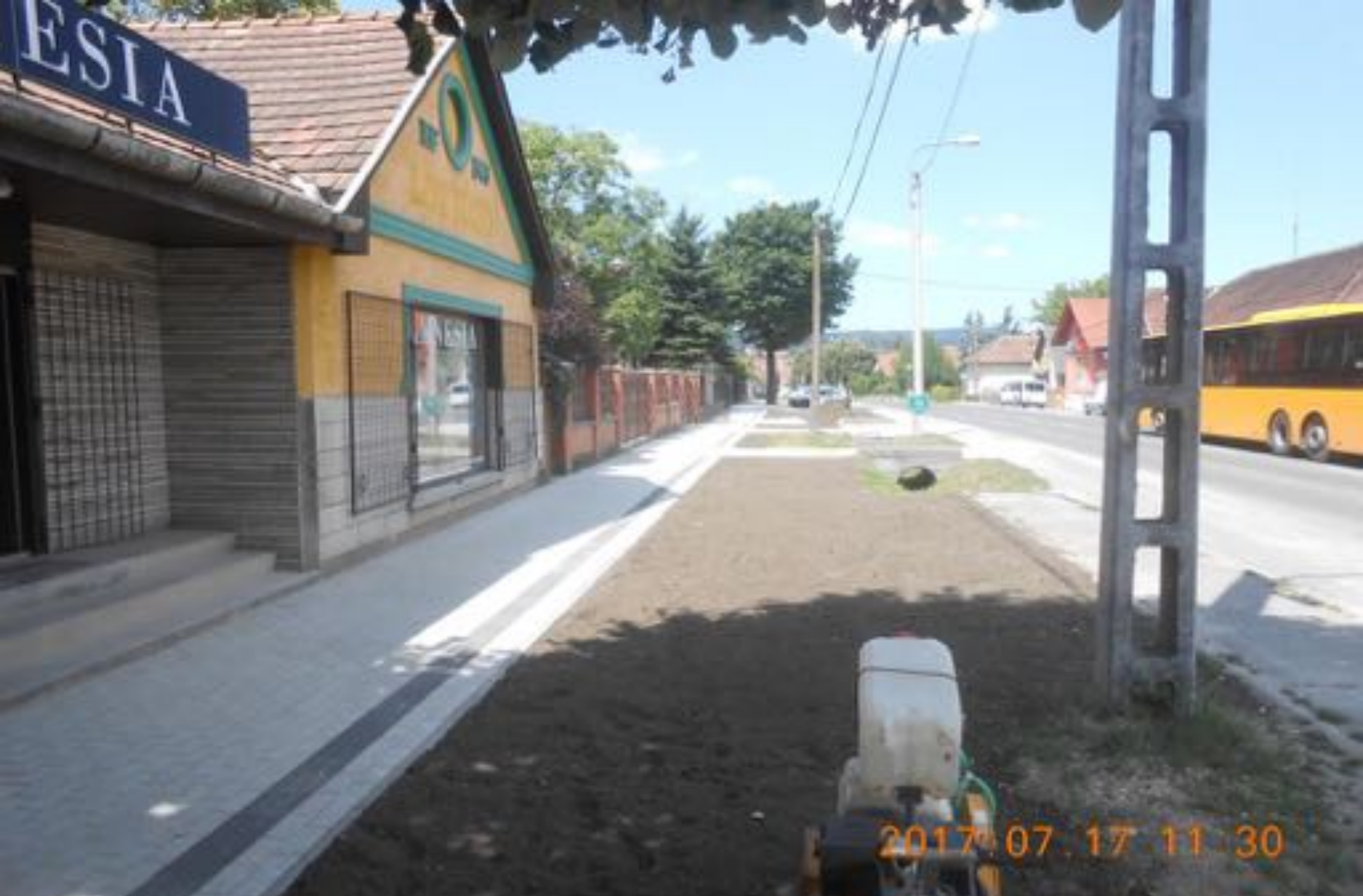
2017.09.15. Járdáépítés a Fő utca Gesztenye u.- Ady Endre u. közötti szakaszán 13 061 950 Ft
